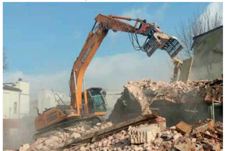
Die hydraulischen Komponenten einschließlich Zylinder, Schläuchen und Drehmotor sind geschützt angeordnet. Die **ASG** Abbruch-Sortier-Greifer der Serie **PMZ** werden aus hochwertigen, verschleißfesten Hardox/Vergütungsstählen gefertigt, die eine hohe Widerstandsfähigkeit, geringe Instandhaltungskosten und eine hohe Rentabilität erreichen.
